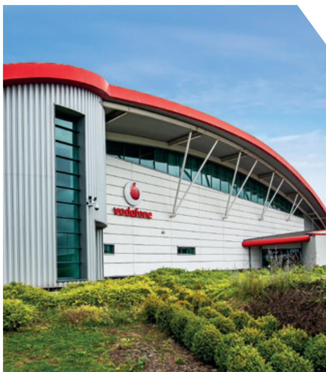
\\ Vodafone - Stoke-on-Trent - UK - Acquis le 01/07/2019
